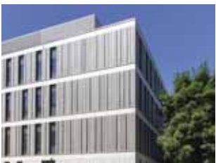
Portalklinik LMU, München. LUDES Architekten – Ingenieure GmbH, München
